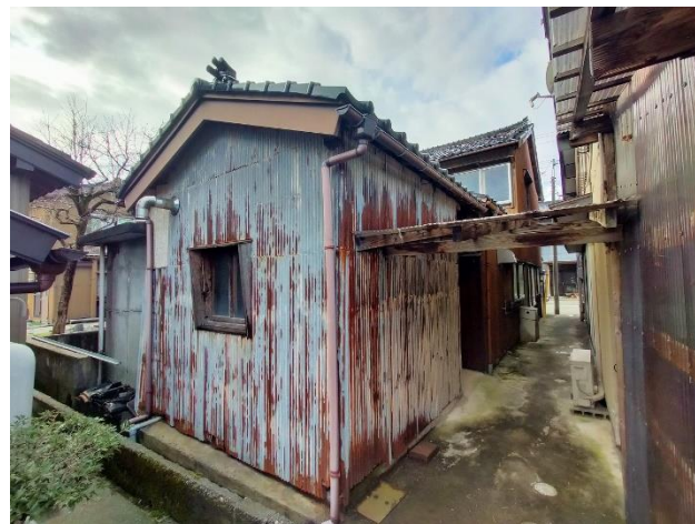
車庫外観 (東側)
