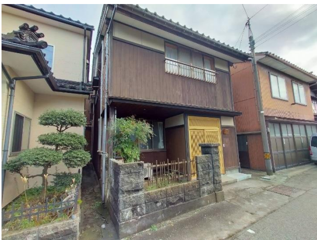
外観（北側隣家との間）
