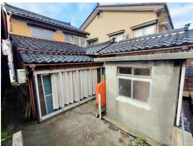
車庫外観 (東側)
