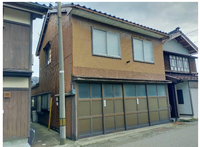
車庫外観（西側正面）
