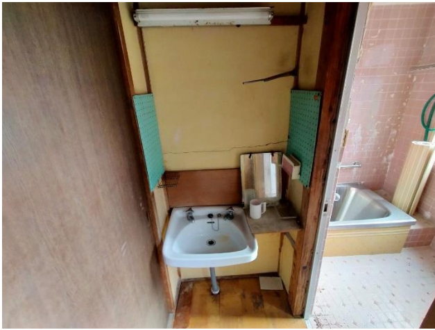
車庫1階 手洗い場
