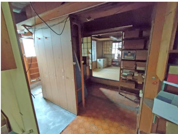
1階 控室への通路
