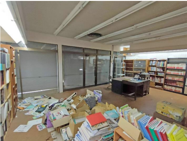
入口 (内側より)
