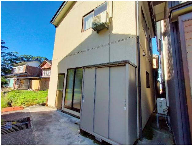
離れ外観（南東側）
