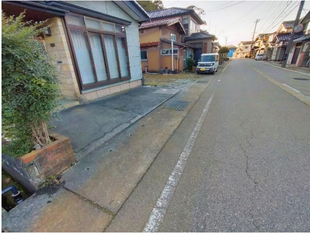
接道状況（敷地北側、西向き）
