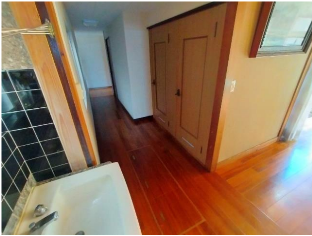
1階 トイレ前、離れへの廊下
