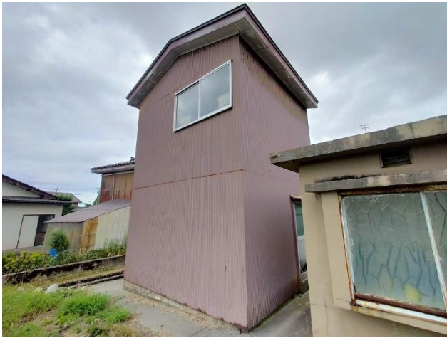
納屋外観（南東側）
