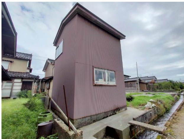
納屋外観（北西側）
