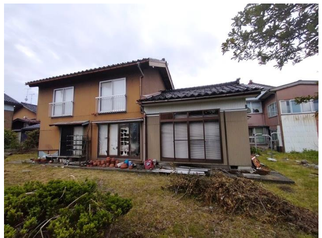
建物外観（西向きに撮影）
