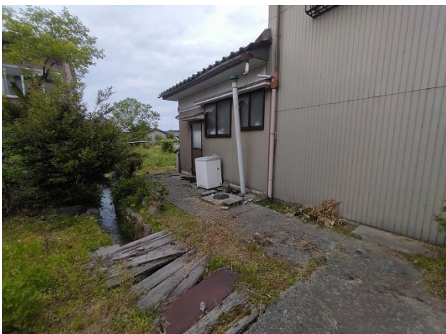
建物外観（東向きに撮影）、洗濯機置き場
