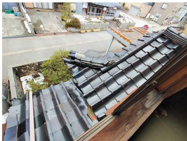
玄関側屋根の状況
