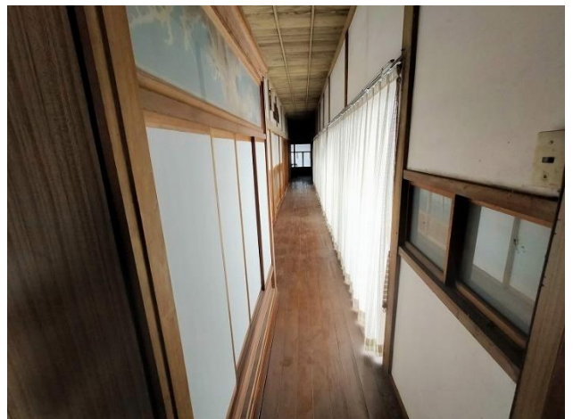
1階 廊下（物置側から玄関側を撮影）
