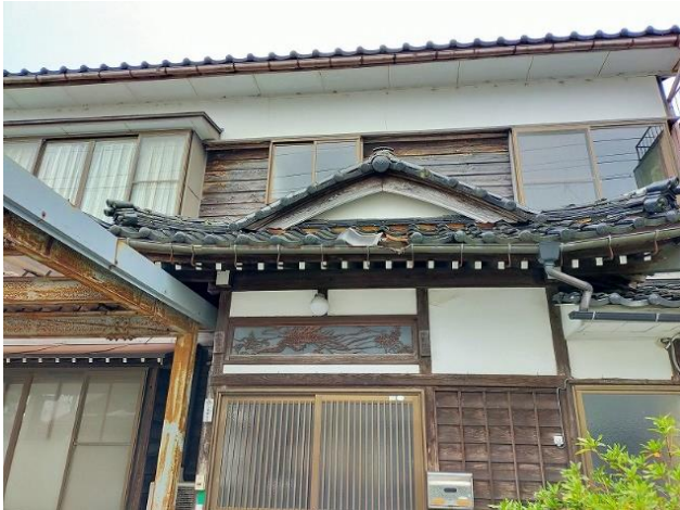
玄関屋根の状況
