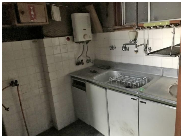
1階 居住部分台所
