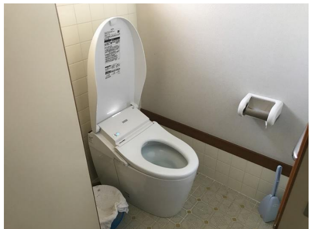
納屋2階 トイレ（大）
