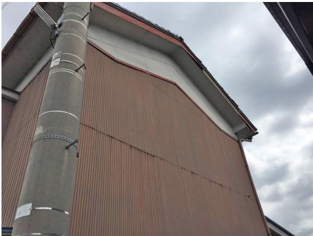
外壁上方（南側）
