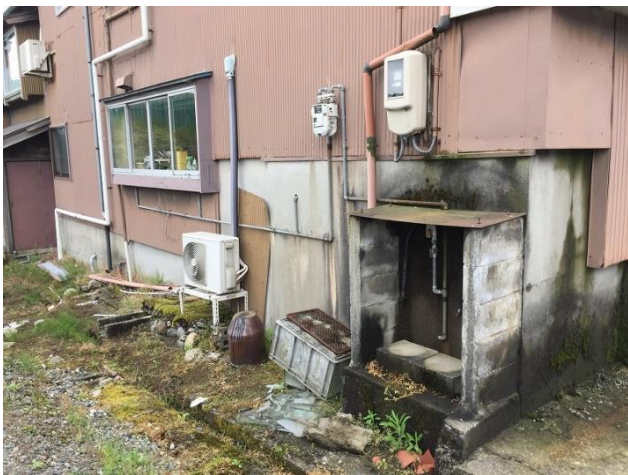
外壁（北側手前）
