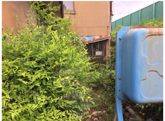
建物裏（東側・ボイラー置き場勝手口）
