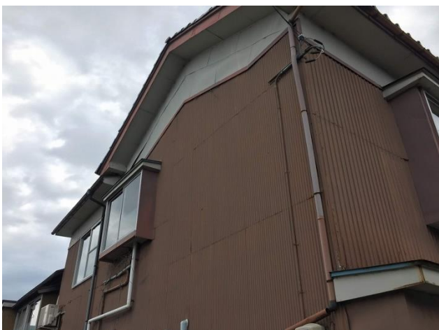
外壁（北側上方）
