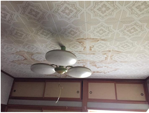
1階洋室6帖天井（前2階洋室10帖の床下）
