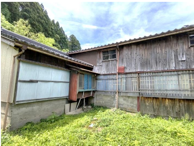
外観（建物南東側）
