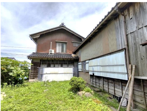
外観（建物南西側）
