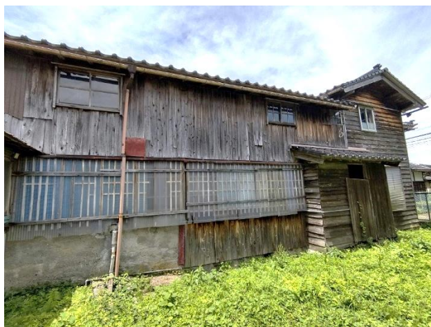
外観（建物東側）
