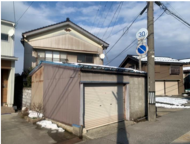
倉庫車庫側の外観
