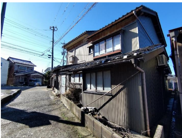
外観（東側、北側）
