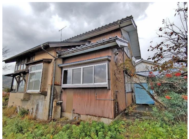
母屋外観 (西側、キッチン寄り)
