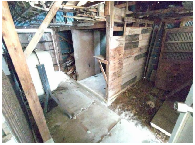
1階 勝手口を出たところ (灯油タンク置き場)
