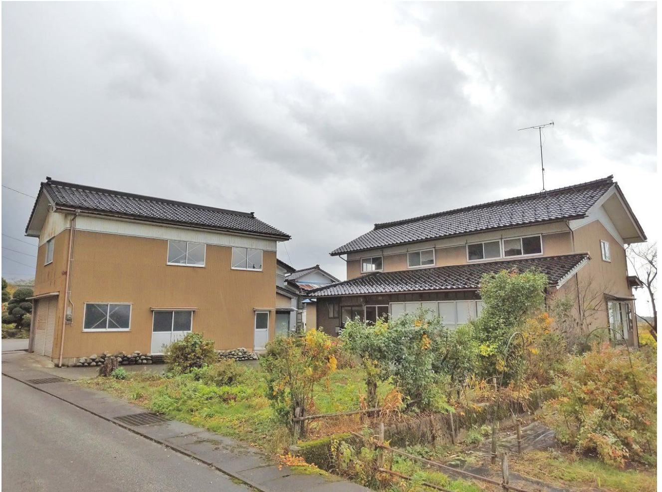
母屋、倉庫 外観
