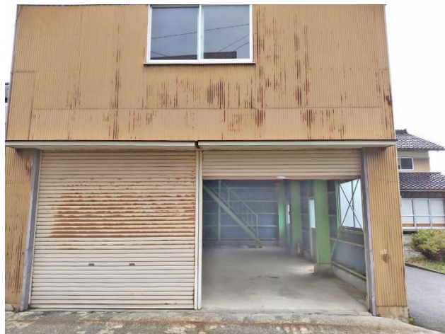
倉庫シャッター（東側）
