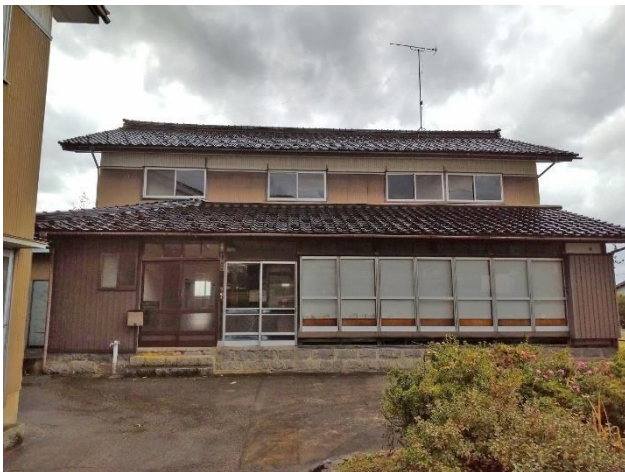
母屋外観 正面（東側）
