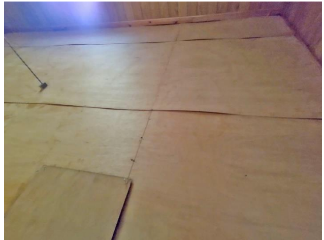
1階 和室5.5帖Aの天井
