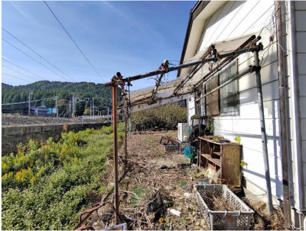
線路脇の状況（南側、西向き）
