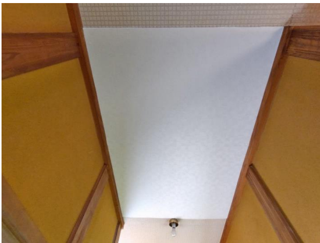
1階 天井 修繕跡
