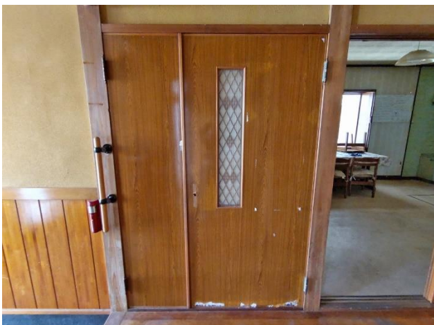
1階 洋室8帖扉※壁仕様（閉まっている）
