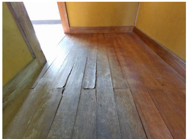
1階 廊下 床 (脱衣所前)
