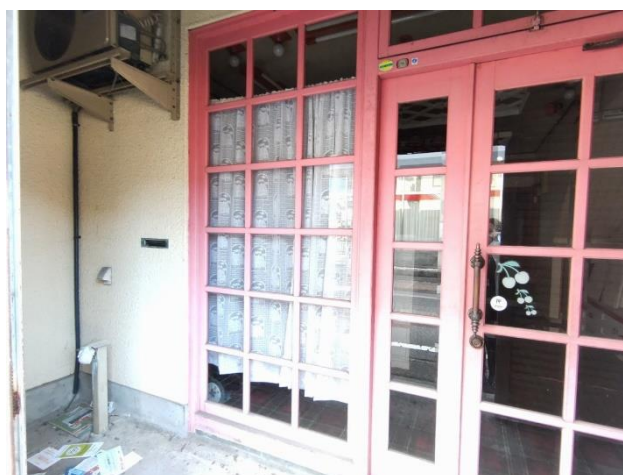
シャッター内 店舗玄関前
