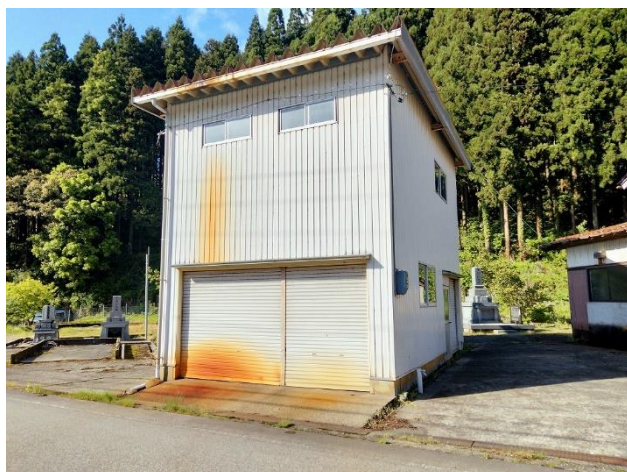
車庫兼作業場
