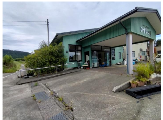
建物外観（入口スロープ別角度）
