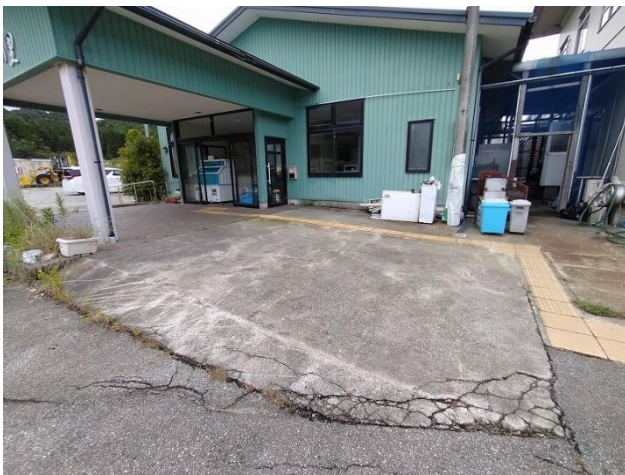
建物外観（入口スロープ）
