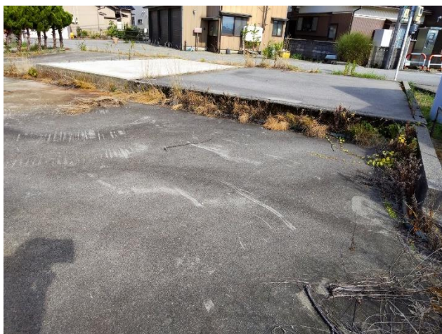
敷地手前（北側より撮影）
