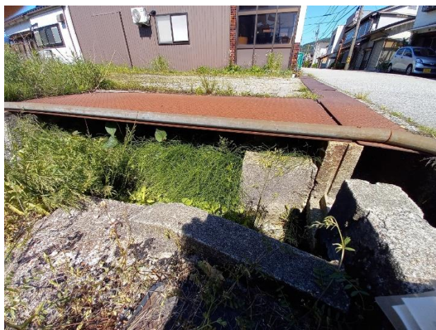
敷地西端の様子
