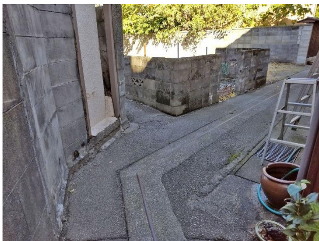
接道状況（西側手前）
