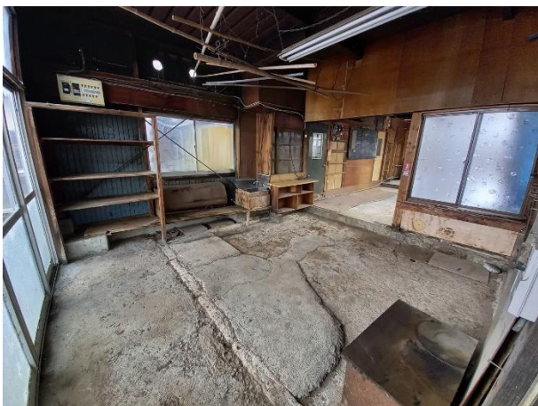
1階 作業場（正面左側）
