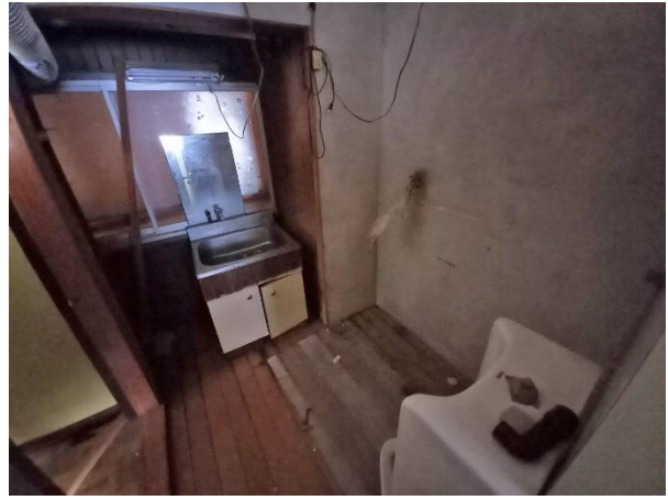
1階 トイレ前手洗い
