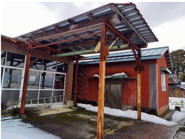
屋根付き駐車スペース
