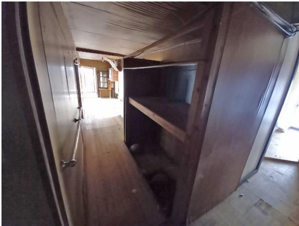
1階 台所・作業場への廊下
