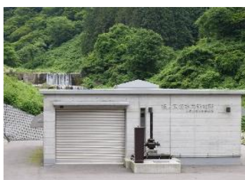
▲相ノ又小水力発電所
