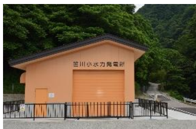
▲笹川小水力発電所
