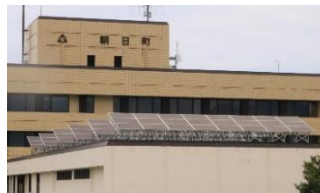
▲太陽光発電設備（役場庁舎）
