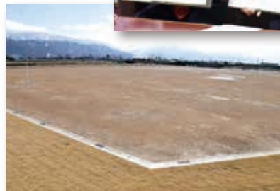
▲契約を締結した草野地内の工場用地
