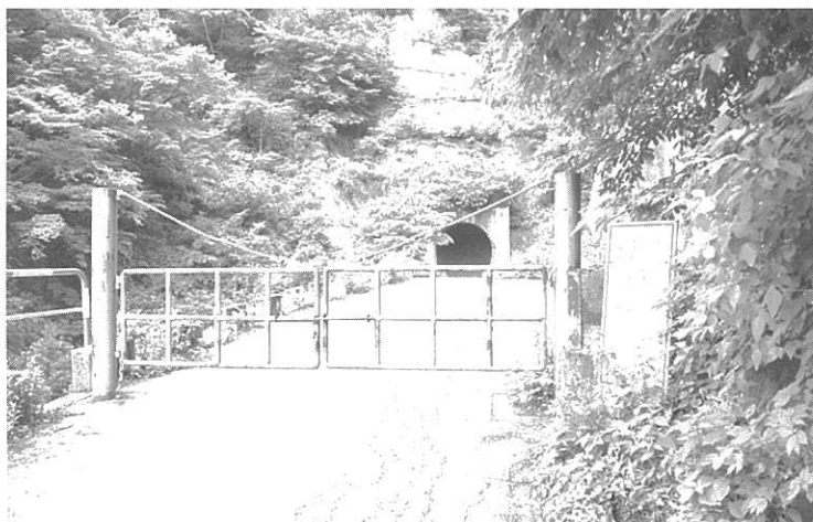
町道湯ノ瀬北又線の起点にある通行制限のためのゲート
