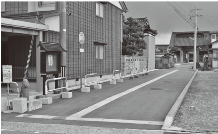
道路に埋設されている耐震型防火水槽（西下町）
