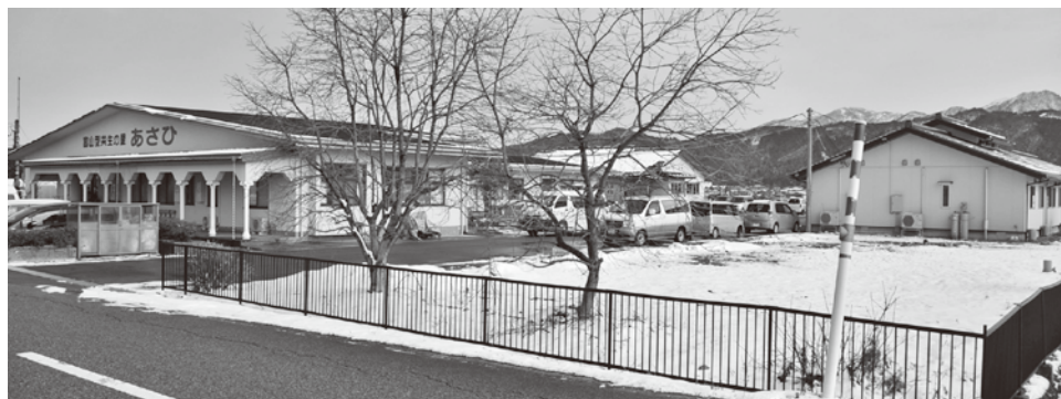
認知症の高齢者と障害者が生活を共にする「共生型グループホーム」建設地(大家庄地内) ＝ 老人福祉施設費の建設補助金を活用
