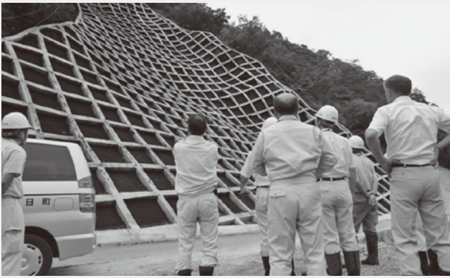
総務産業委員による町道湯ノ瀬北又線の災害復旧現地調査
