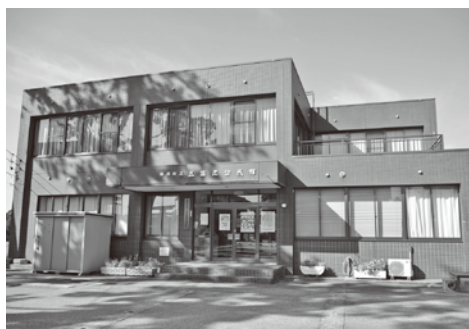
防水工事を行う五箇庄公民館
