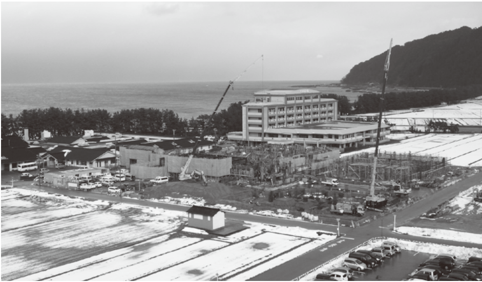
有磯苑の増床工事（1/13撮影）
