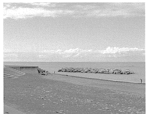
本年度完成予定の宮崎漁港沖防波堤
