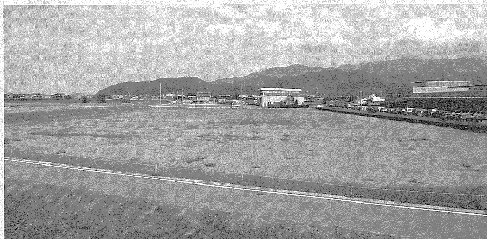
企業誘致のため造成された工場用地（草野地内）
