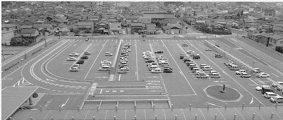
あさひ総合病院の駐車場
