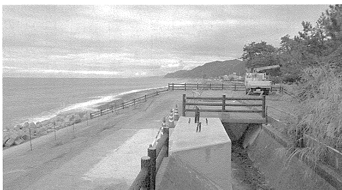
CCTV定点カメラ設置箇所（大谷川河口付近）
