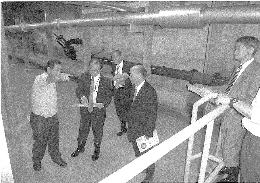
朝日浄化センターの現地調査
