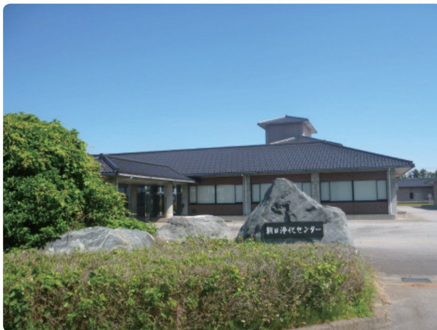
朝日浄化センター
