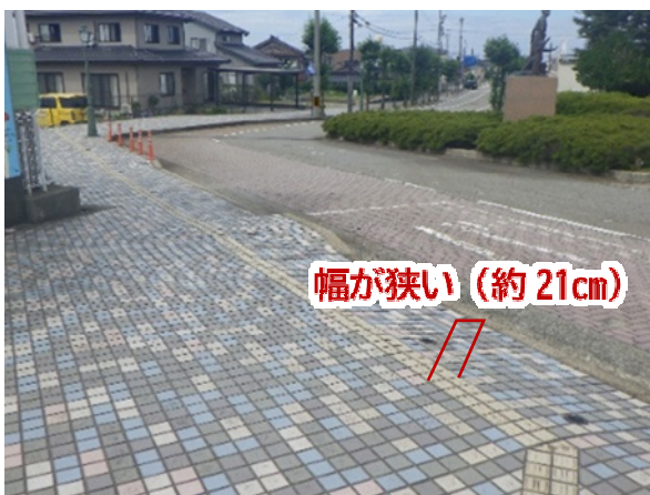
視覚障がい者誘導用ブロックが適切に配置されていない (規格が現行基準にあっていない)
