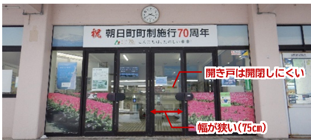
出入口の幅が狭く、建具が開閉しにくい
