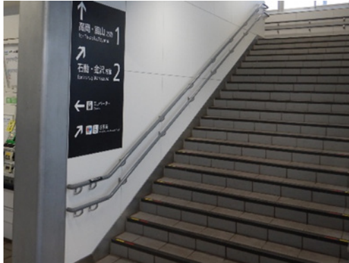
階段のバリアフリー化検討 （手すりの設置）
