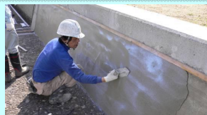
老朽化した水路壁のコーティング
