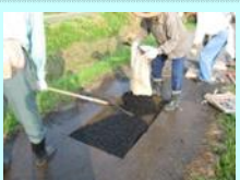
農道の部分補修
