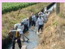
水路の泥上げ
