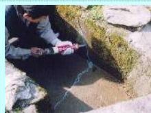
水路のひび割れ補修
