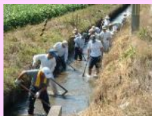
水路の泥上げ
