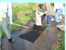
農道の部分補修
