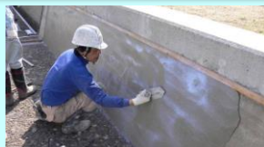
老朽化した水路壁のコーティング
