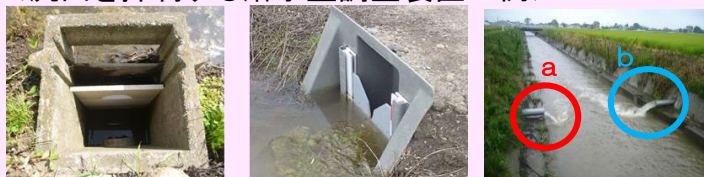
a 田んぼダム実施 b 田んぼダム未実施
