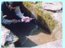
水路のひび割れ補修
