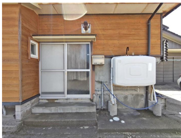
勝手口、灯油タンク
