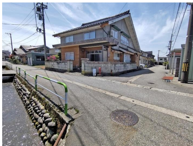
接道状況（南向き、西向き）
