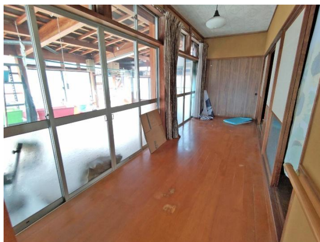
Ⅰ階 廊下（西向き）
