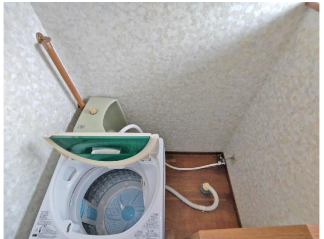
1階 洗濯機裏・トイレ跡
