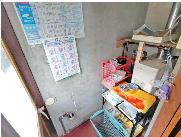
1階 ボイラー室、勝手口
