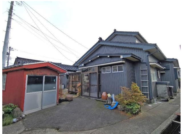
小屋・母屋外観
