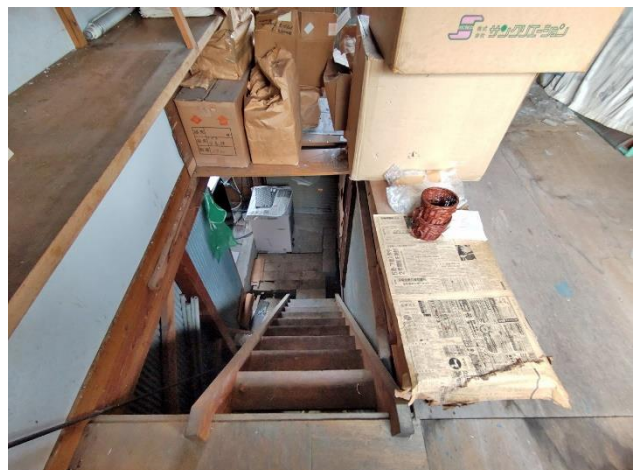
倉庫2階 見下ろした階段
