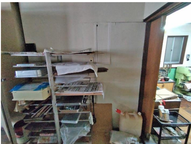
1階 風呂入口跡 (風呂未確認)
