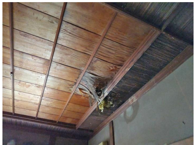
1階 和室8帖C 天井
