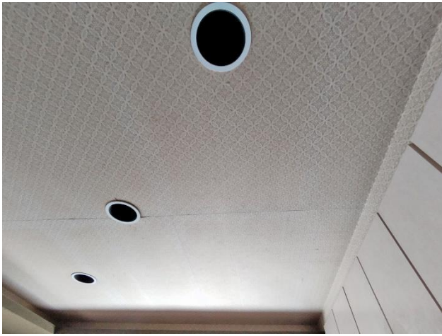
2階 洋室10帖A 天井(照明部)
