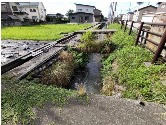
敷地前の川（北向き）
