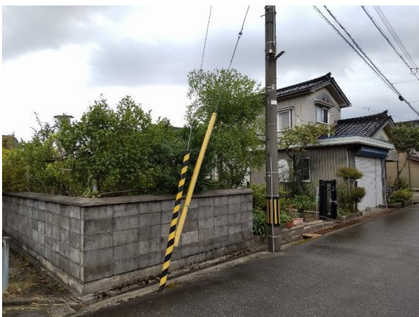
敷地南西側ブロック塀
