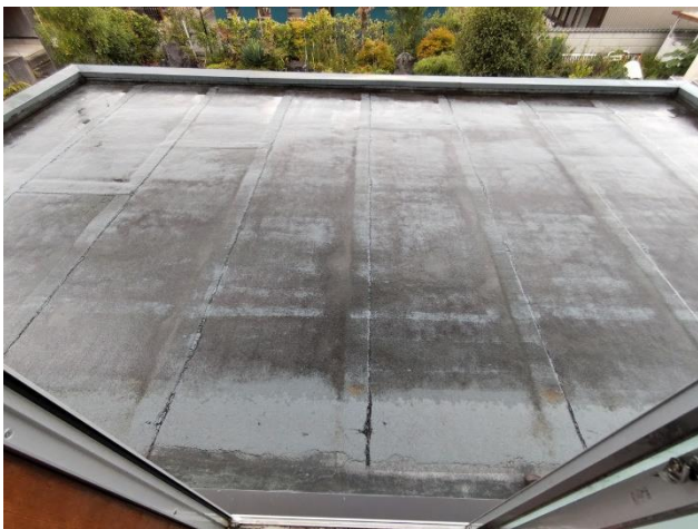
2階 洋室8帖から見たS造部陸屋根
