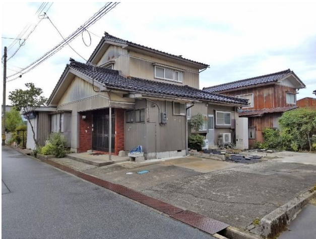
外観（南東側）、駐車スペース
