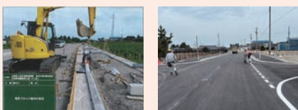
(都市計画道路工事)
