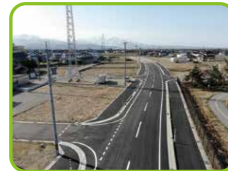
国道8号停車場線
