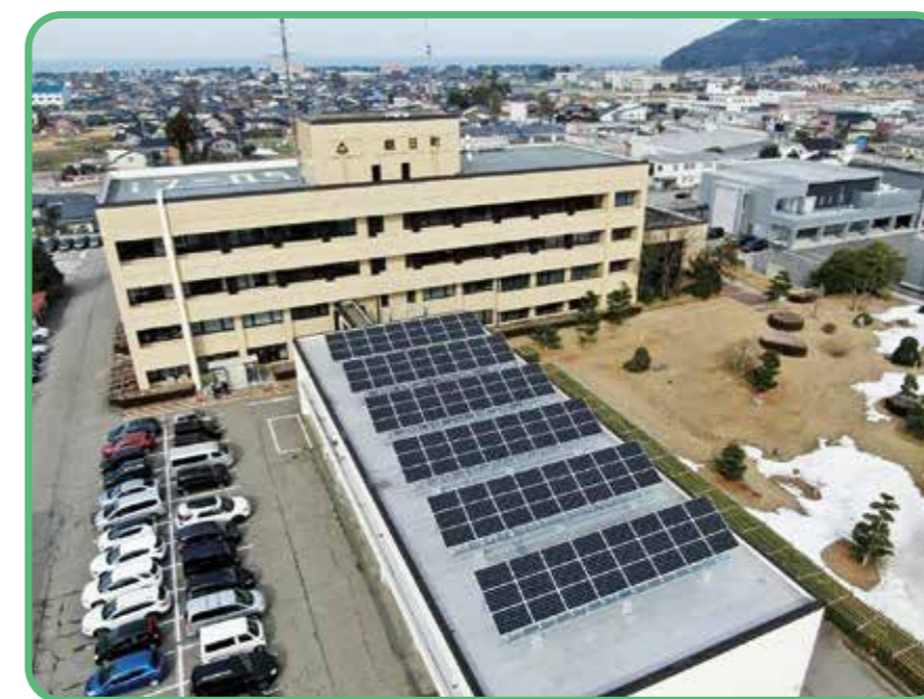
太陽光発電（朝日町役場庁舎）
