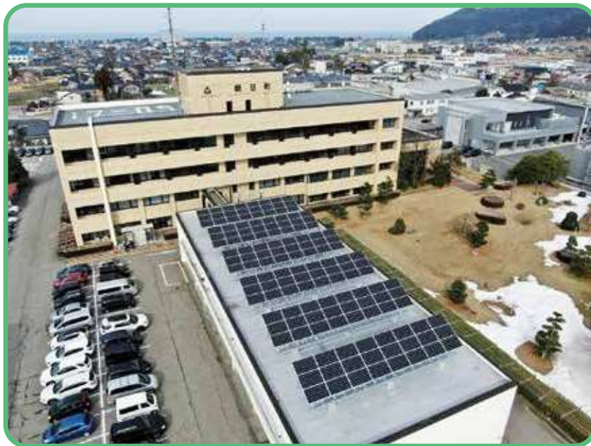
太陽光発電（朝日町役場庁舎）
