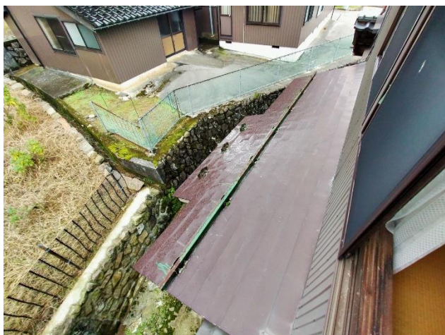
東側2階 和室4.5帖から見た屋根
