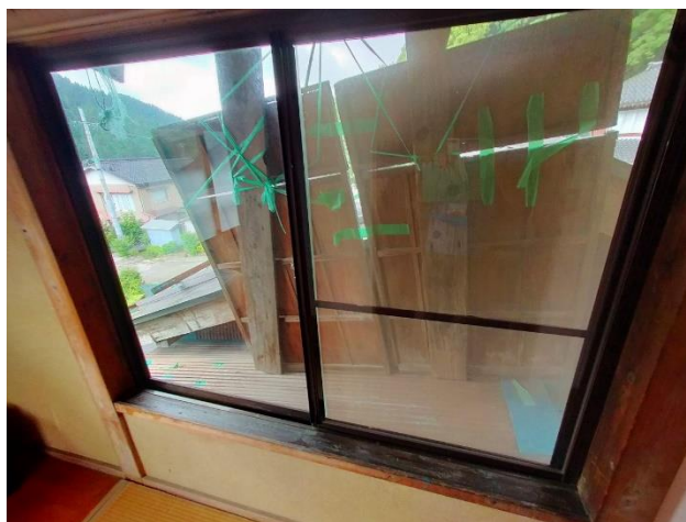
西側2階 廊下窓の雪止め
