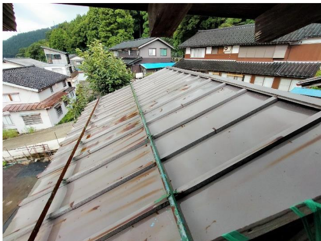
西側2階 廊下からみた屋根
