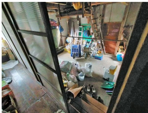
Ⅰ階から納屋への接続口
