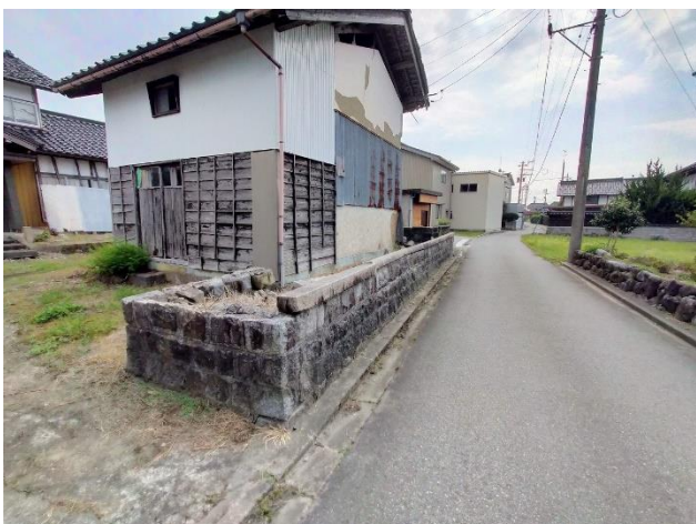
接道状況 ※土蔵は解体予定
