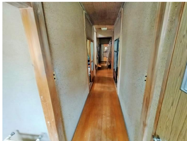
1階 廊下 (トイレ側から和室方向)
