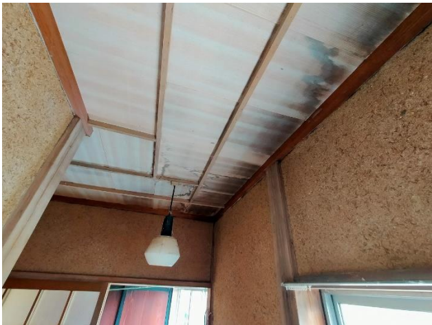
2階 廊下の天井
