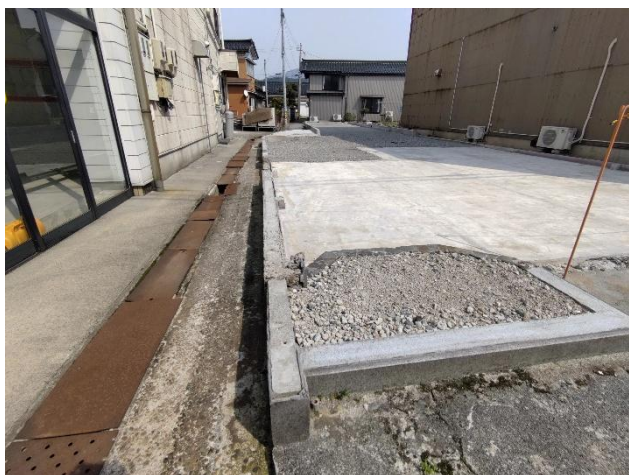
敷地北側境界（手前）
