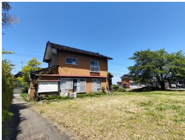
敷地南側通路
