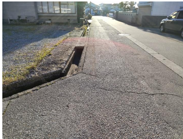
敷地北側の接道状況(西向き)
