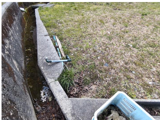
敷地奥 南東の境界
