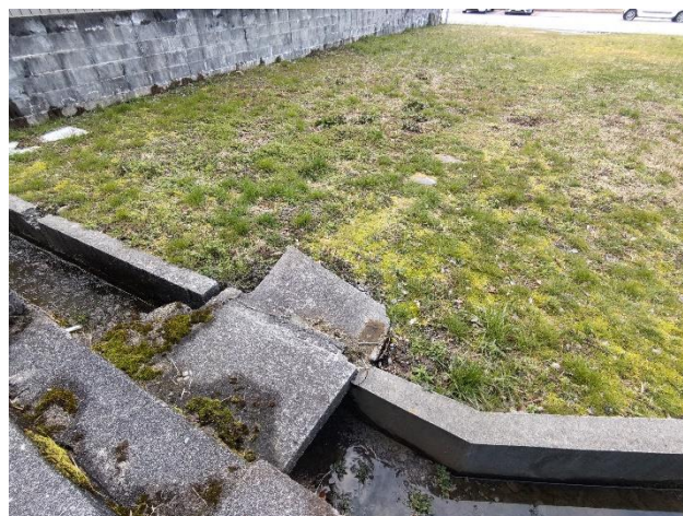
敷地奥 中央付近の様子
