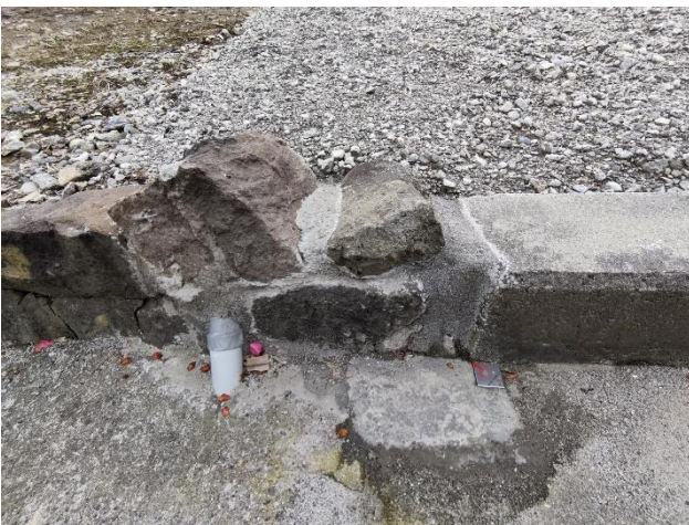
敷地手前 北端の境界
