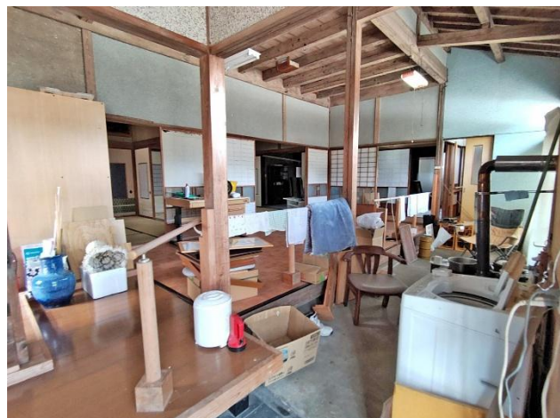
1階 ホール、土間
