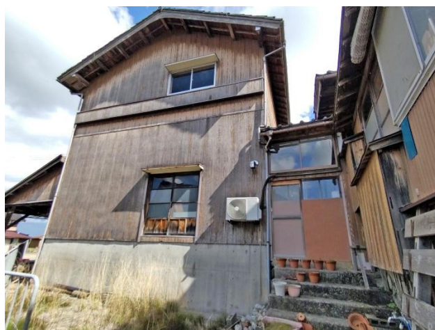
外観（西側、納屋部）
