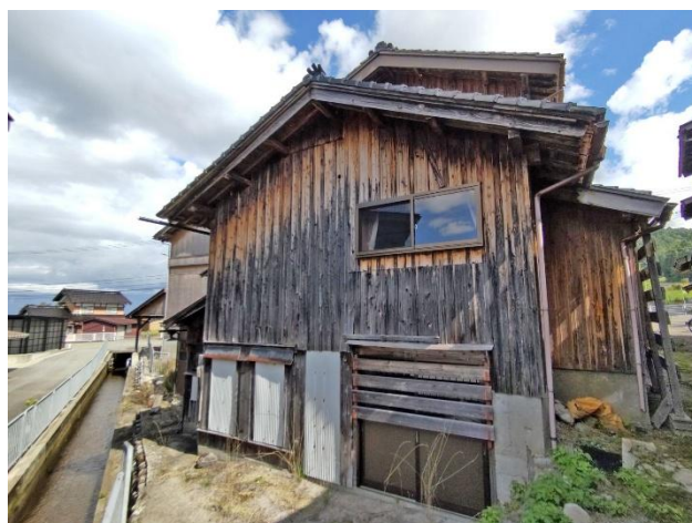
外観（西側、地下室入口）
