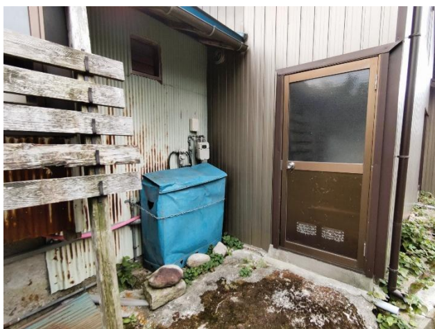
ボイラー室入口
