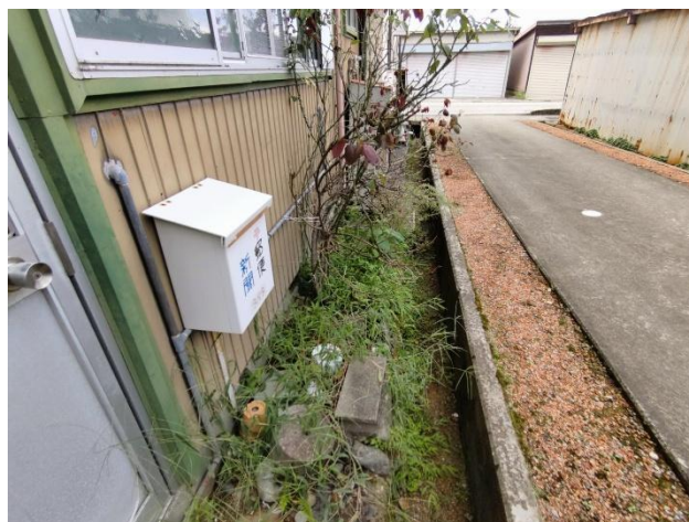
敷地境界（北側）
